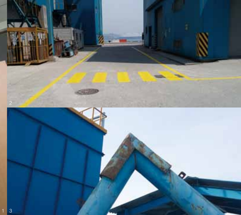
1. 안전사고 예방을 위한 아침 국민체조 2. 차량 안전 운전을 위한 바닥 도색 3. F/A 이동 배관 곡각부 강판 보강
