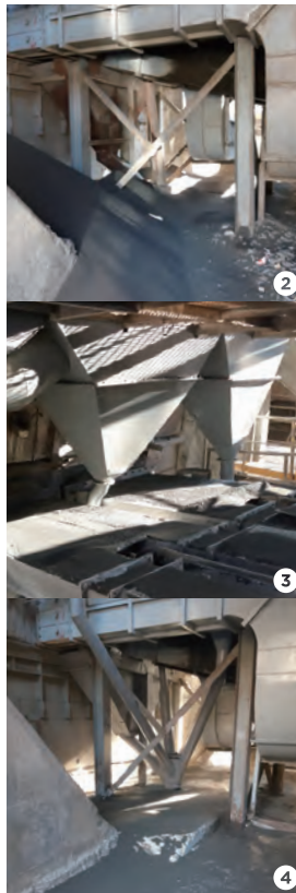
1 설비시멘트 생산기획팀 혁신사무국의 가장 중요한 업무 도구는 소통이다. 2 미세 클링커가 오랜 시간 쌓인 모습. 3, 4 누출되는 클링커를 포집하는 호퍼형 슈트를 설치하고 이송 장치까지 연결해 환경 개선, 비용 절감, 생산량 증대라는 일석삼조의 개선을 이루었다.
