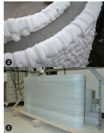
1, 2 프랑스 낭트대의 3D 프린팅 건축 현장. 폴리아우레탄 폼을 이중으로 쌓고 그 사이에 콘크리트를 채웠다. 3 2006년 베룩 코시네비스 교수가 논문(Mega-scale fabrication by contour crafting)을 발표하며 제작한 1.5m 길이의 3D 프린팅 콘크리트 구조물.
